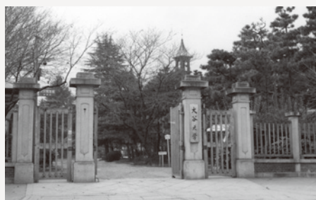
1950年頃の大学正門 (門柱は現北門として使用)
